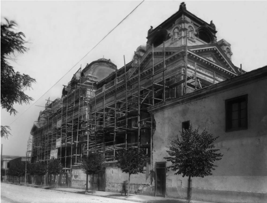
La construcción de la Biblioteca Nacional, circa 1913, que reemplaza al antiguo Convento de las Clarisas
